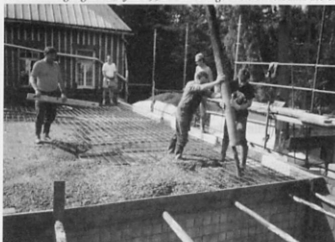
Betonieren der Erdgeschoßdecke am 9. Oktober 1992
