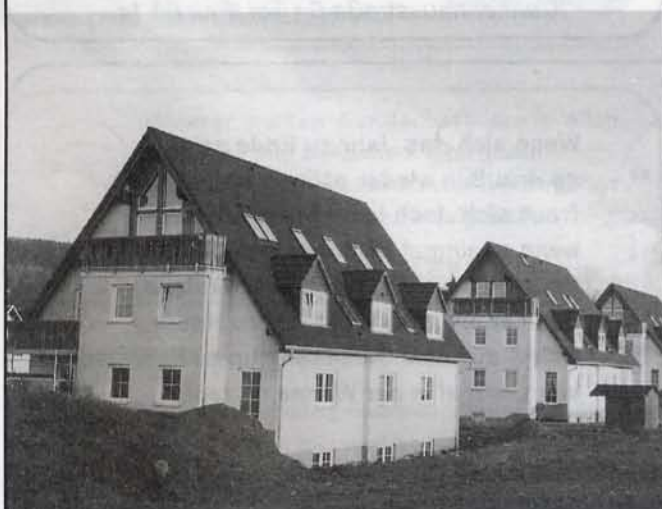
Eigenheimsiedlung Schwarzbacher Weg
