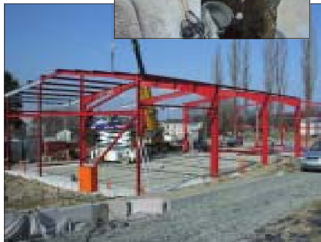
Gewerbegebiet am Bahnhof, Firma Bretschneider
