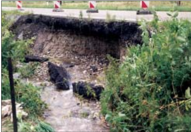
Unterspülungen an der Staatsstraße S 268 in Richtung Kalkwerk
