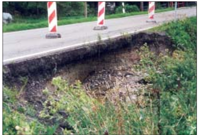
Unterspülungen an der Staatsstraße S 268 in Richtung Kalkwerk
