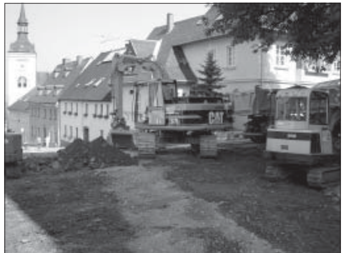
Grundhafter Straßenbau Kirchgasse
