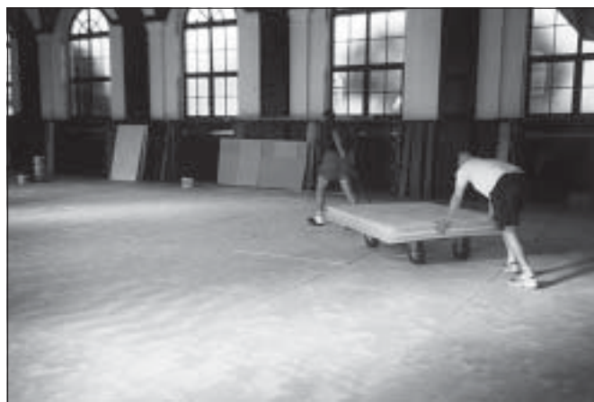
Die Turnhalle während den Bauarbeiten
