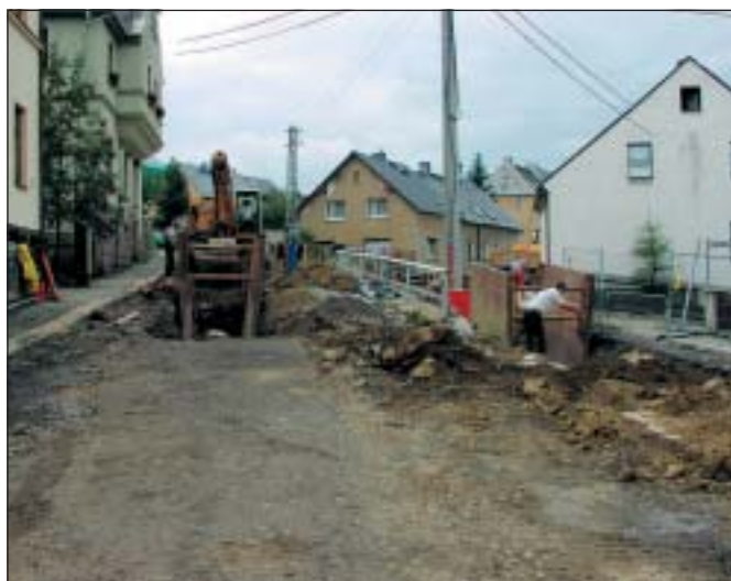
Kanalbau Lehmannstraße - Rudolf-Breitscheid-Straße
