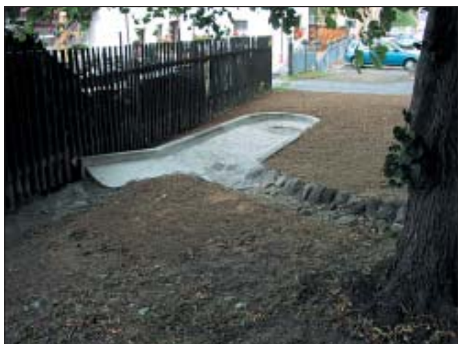
Einlaufbauwerk im Stadtpark
