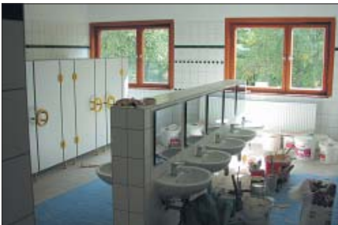
Die Sanierung im Obergeschoss des Kindergartens ist fast abgeschlossen.
