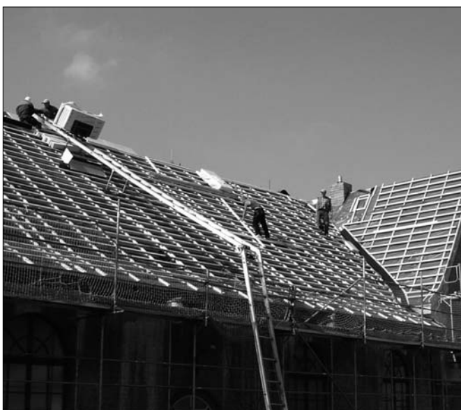
Dacharbeiten an der Turnhalle - ermöglicht durch eine großzügige Förderung des Freistaates Sachsen
