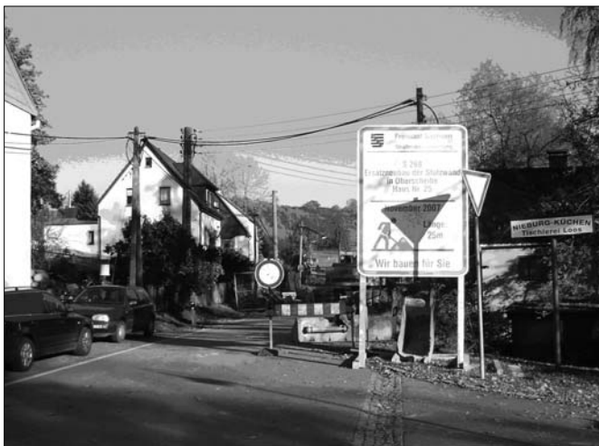
Baustelle an der Hauptstraße Nr. 25
